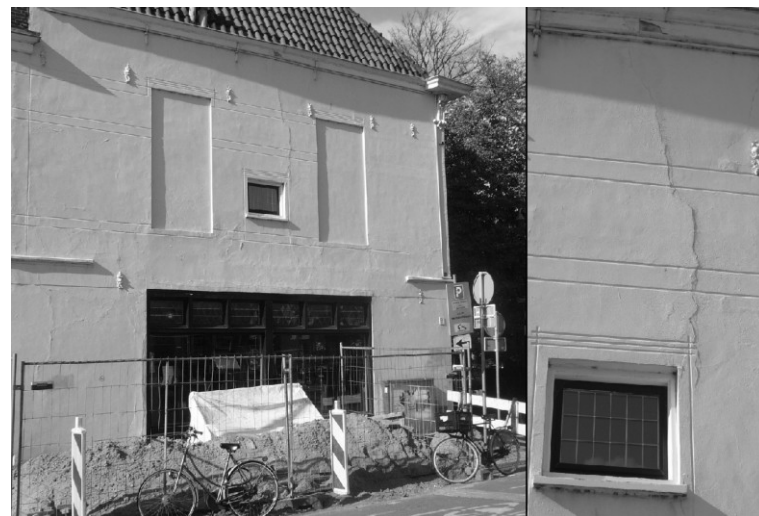
Door de werkzaamheden zijn er scheuren ontstaan in het pand op de hoek van de Veenkade en Toussaintkade.
